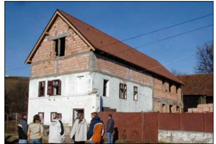
Das Ferien- und Seminarhaus im Rohbau
